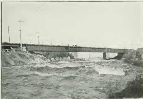
Intercolonial Railway, Mont Joli Subdivision. Rivière du Loup Bridge.
